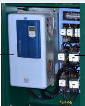
ARRANCADOR ESTRELLA - TRIÁNGULO
